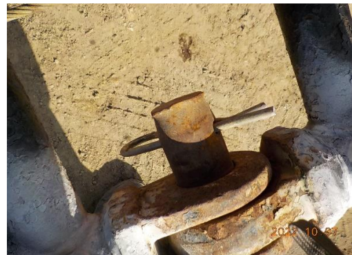
와이어 이탈방지장치 설치 상태 양호
