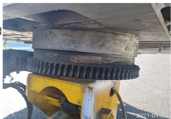
2. 운반구 하부 뮌 기어 상태 / 실린더 상태 점검
