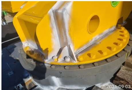
턴테이블/선회장치 볼트 풀림상태 점검
